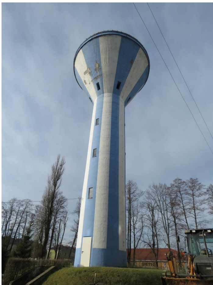
Rys.2. Ogólny widok wieży zbiornika wodnego w Zawadzkiem
