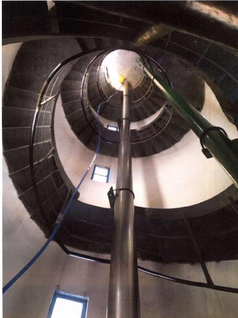
Rys.4. Obraz wewnętrznej części trzonu wieży zbiornika na wodę w Zawadzkiem
